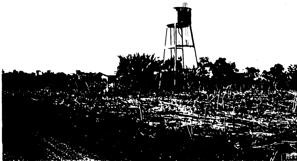
FOTO N.º 1: TORRE DE ALMACÉN que forma parte del Sistema de Agua Corrientes de la Ciudad Mariscal López - Futura Capital.
