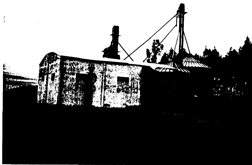
FOTO 23: PLANTA DE ALMACENAJE - Silos "Ex-Liebig" para maíz, trigo y sorgo - Fracción 3.-
