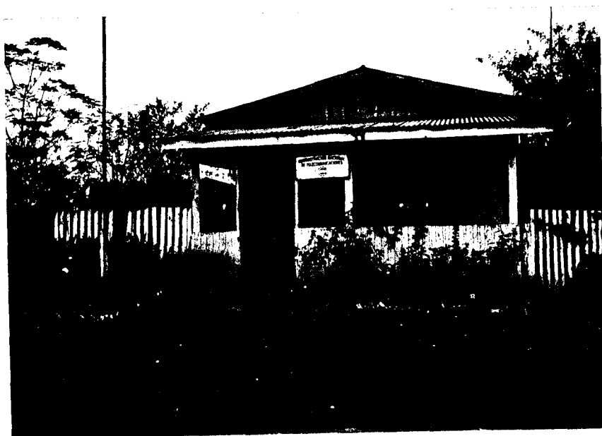
FOTO 17: LOCAL DE "TELICO" Cabina de comunicacion telefonica - Fraccion 4
