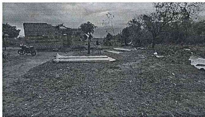
Una de las casas dañadas en el distrito de Belén. (Foto gentileza).
