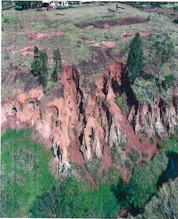
Imagen 5 Desprendimiento de paredes laterales
