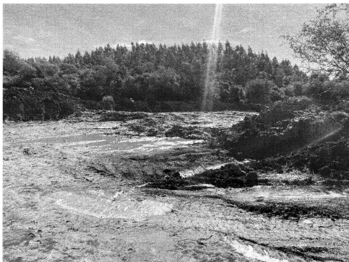
Foto 9 y 10 – Registro de un relleno con desechos de pileta de lixiviación a pocos metros del cauce del arroyo Sanabria y un sistema de humedal colindante al cauce hídrico. (Se observó posible preparación que podría terminar siendo utilizado para pileta de lixiviación).
