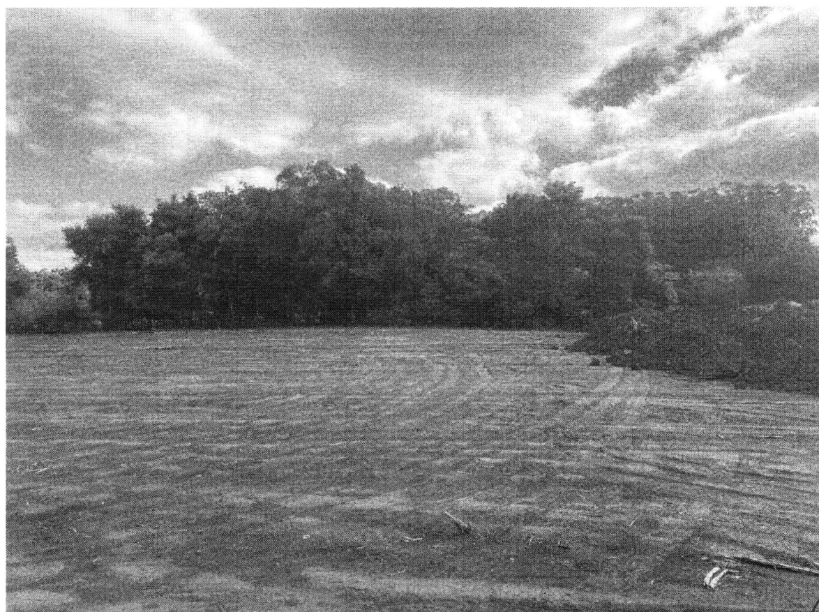
Foto 3 y 4 – Movimiento de suelo para la instalación de una cantera de la compañía Alfonso Cué del Distrito de Paso Yobai.
