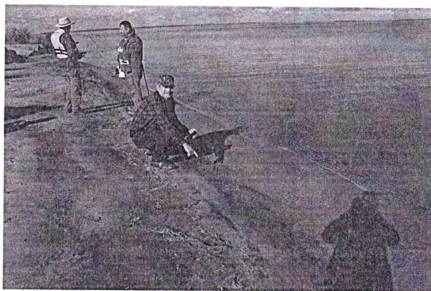
Lado sur de las dunas se observa la erosión y afloramientos
